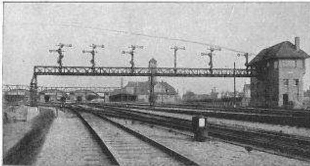
Signalbrücke mit Mastsignalen.
