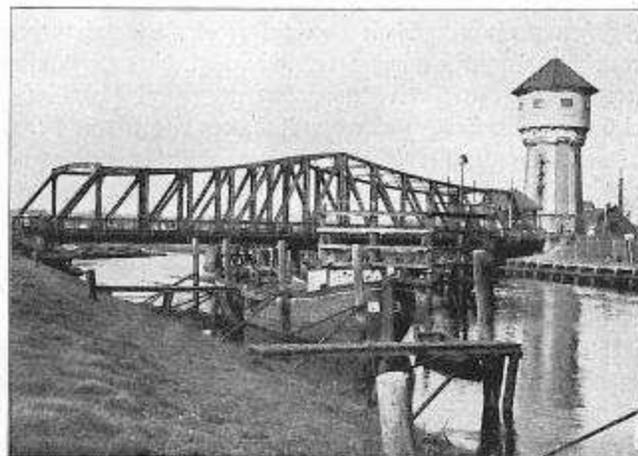
Zweigleisige Drehbrücke über die Sumte bei Oldenburg (geschlossen).
