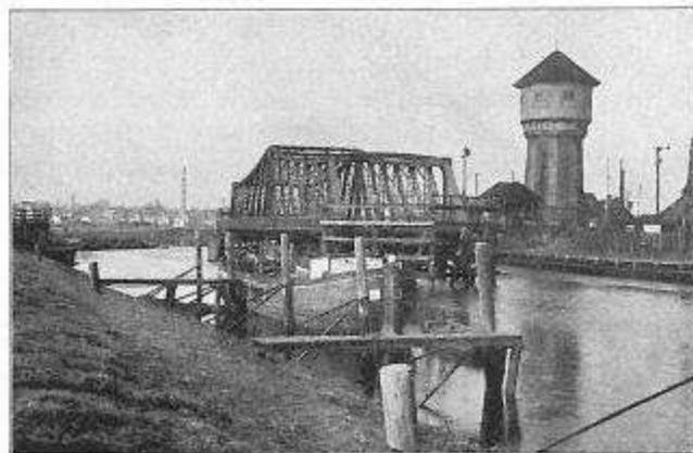
Zweigespannige Drehbrücke über die Hunte bei Oldenburg (geöffnet).
