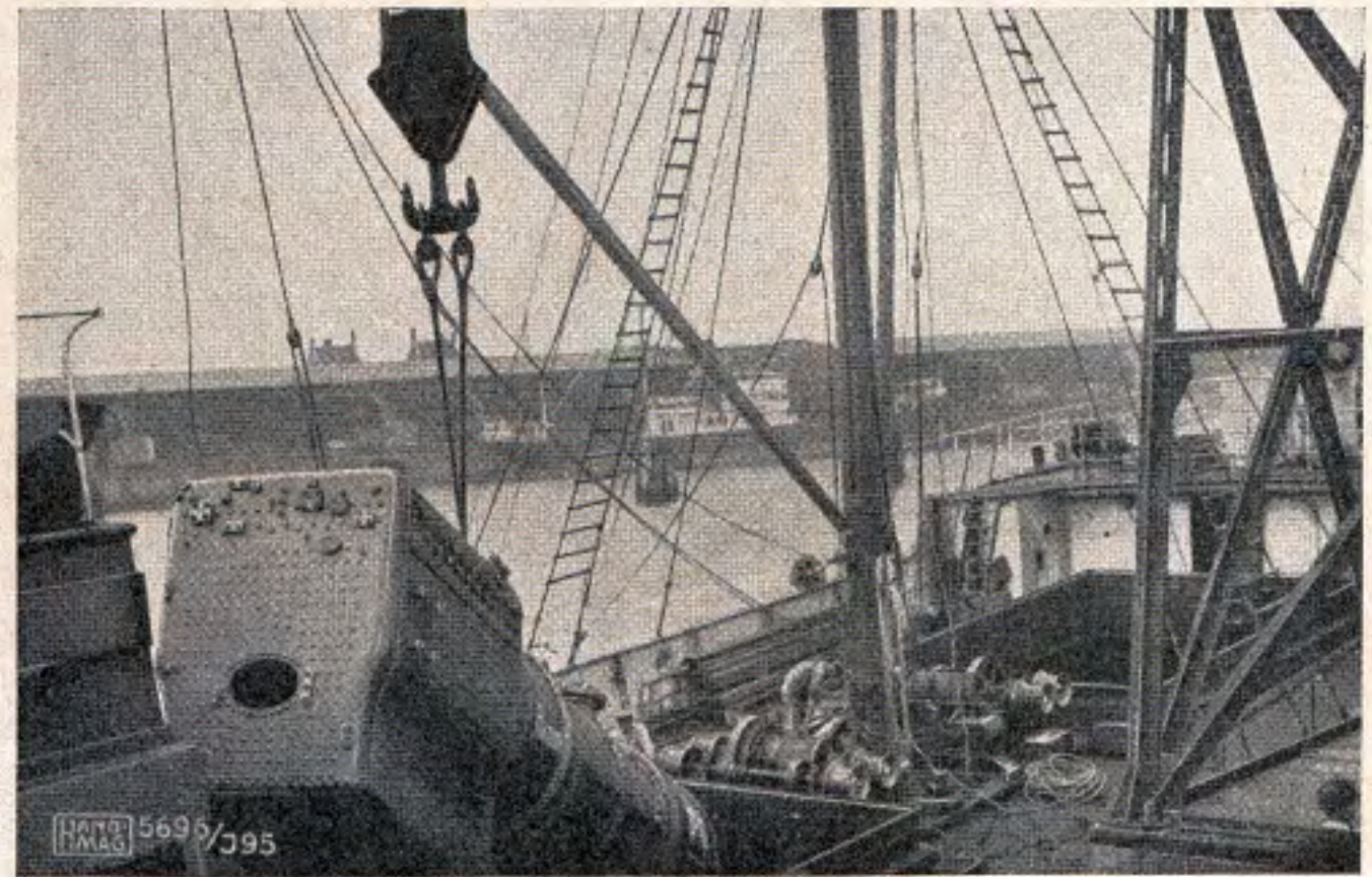
Abb. 79 Das Hereinbringen des Kessels durch die Luke in den Schiffsraum.
