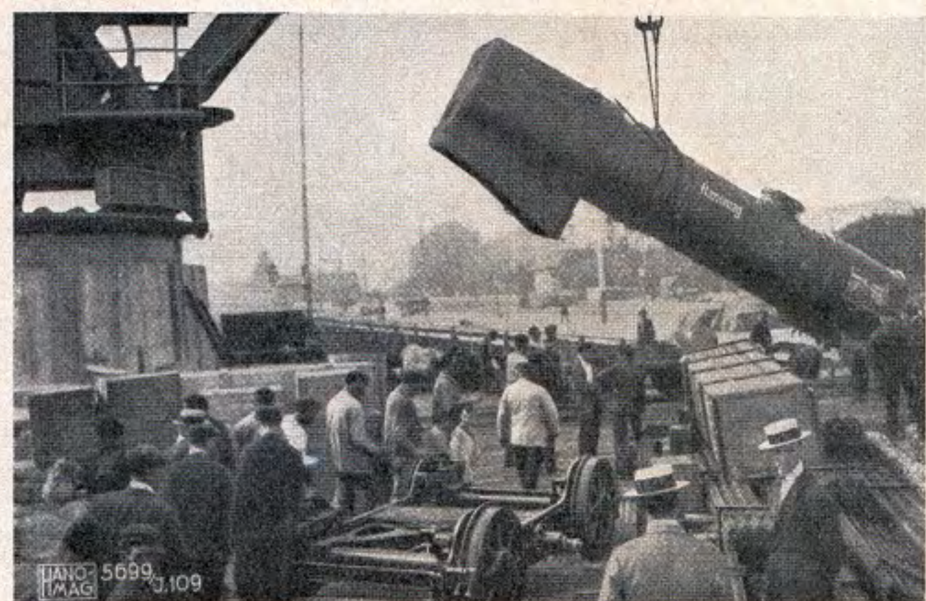
Abb. 82 Absetzen des Dampfkessels auf einen Transportschemel. 5699 Infolge Wagenmangels mußten große und schwere Teile teilweise auf Transportschemel vorläufig abgesetzt und verschoben werden, bis Eisenbahnwagen zur Verfügung gestellt werden konnten.
