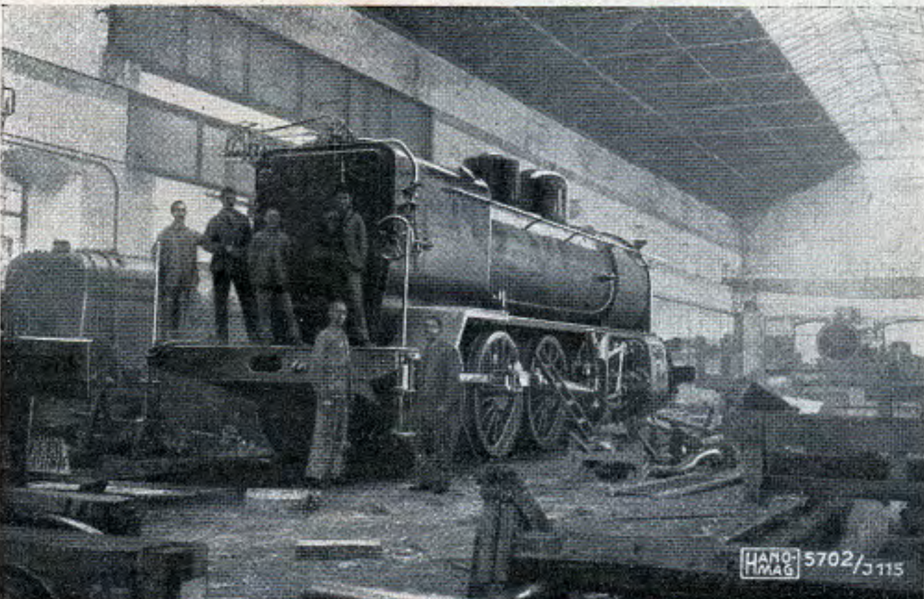
Abb. 85 Beim Zusammenbau der Lokomotiven in Valladolid. 5702 Der Kessel ist auf den Rahmen gesetzt.
