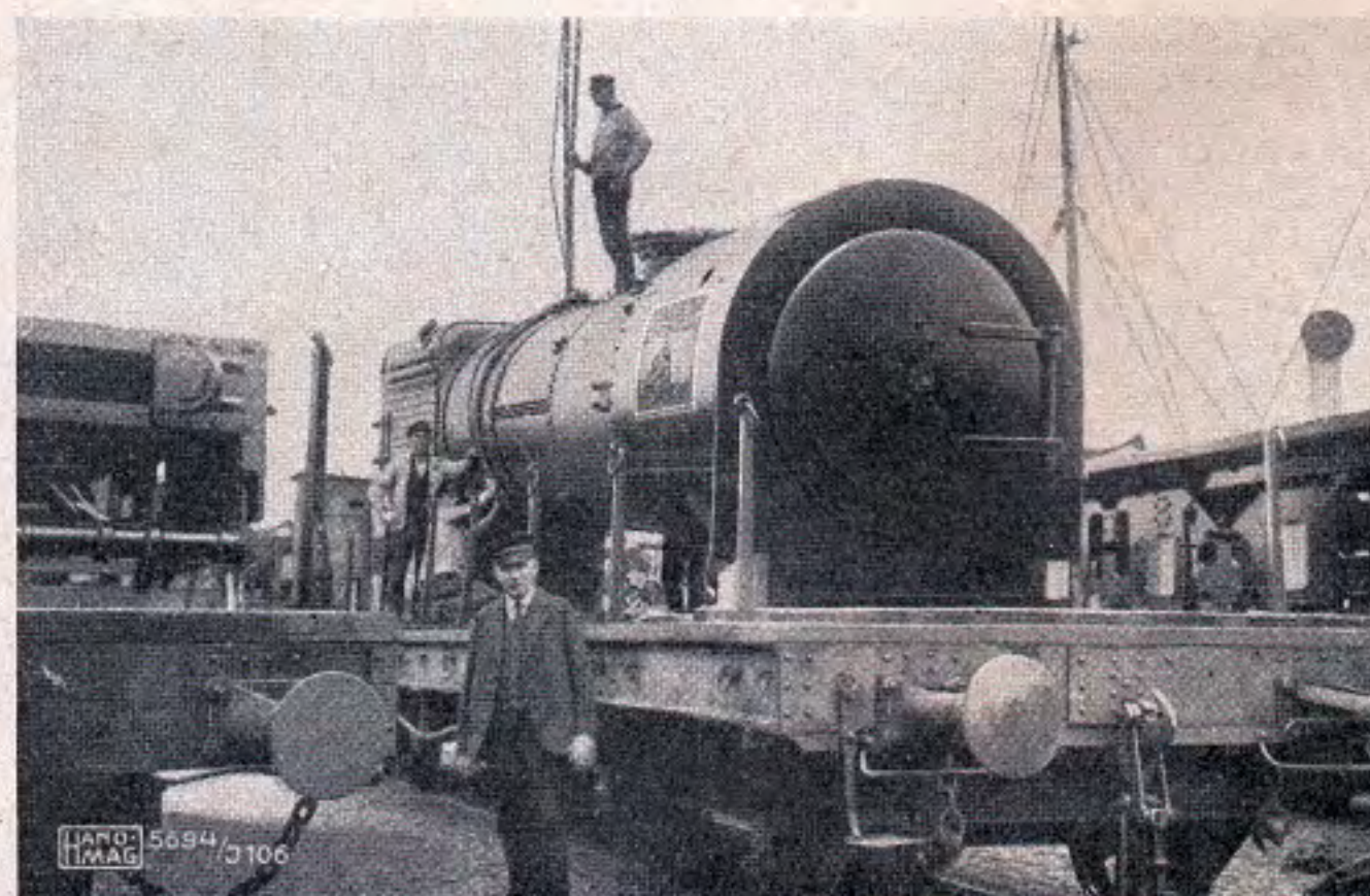
Abb. 77 Um den auf Eisenbahnwagen angerollten Dampfkessel werden Taue gelegt zur Übernahme an Bord des Dampfers. Um Täuschungen bezüglich der Schwerpunktlage zu vermeiden, sind am Kessel Ketten aufgemalt, die dem Verstauer andeuten sollen, wo er die Kranketten anzulegen hat.
